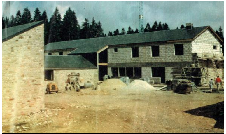
La station scientifique en construction (vers 1974)
